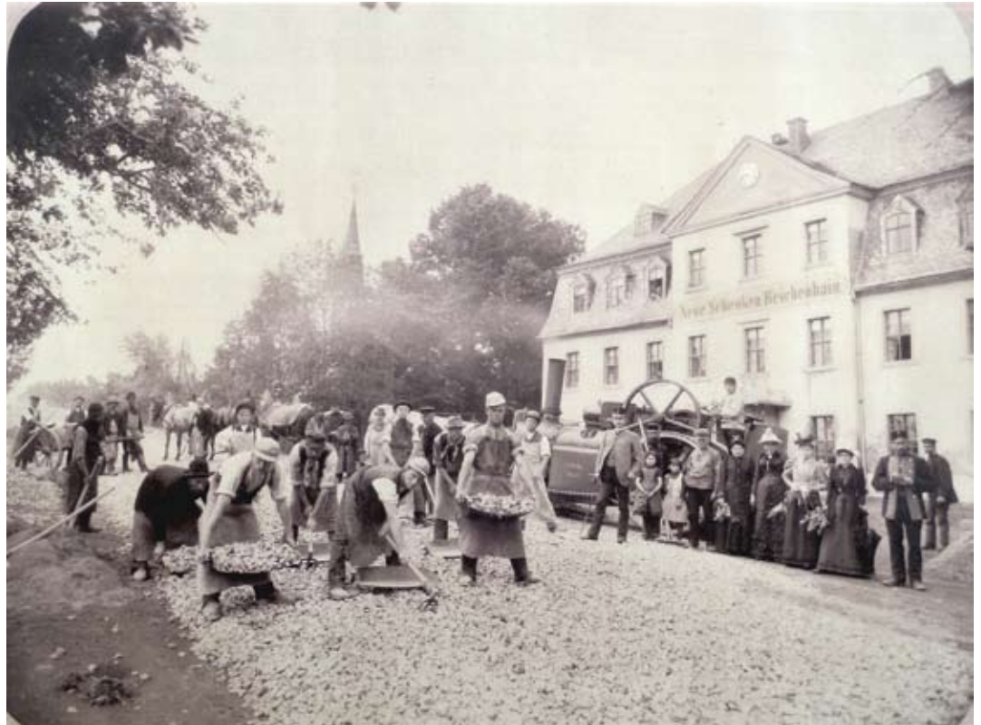
Diese Fotografie entstand um 1890 auf der Zschopauer Landstraße, heute Zschopauer Straße. In stolzer Haltung und mit Gehstock steht Carl Waha vor seiner wohl ersten Dampfwalze. Im Hintergrund ist die „Neue Schenke Reichenhain“ zu sehen. Die Restauration lag unweit der heutigen Einfahrt zur Georgistraße auf der Straßenseite gegenüber. Damen stehen mit blühenden Kastanienzweigen vor dem Gasthof und mehrere vorwiegend südeuropäische Arbeiter sind mit dem Einbringen von Schotter zur Vorbereitung der Pflasterarbeiten beschäftigt. Der Straßenmeister Viktor Rößler steht in königlich-sächsischer Uniform ganz rechts. Er lebte damals in einem Seitengebäude der Schenke. Eine an der Walze ergänzte Verkleidung mit der Firmenbezeichnung „C. Waha – Chemnitz“ ist zweifellos eine Idee Carl Wahas, um den Menschen damals die Angst vor der fauchenden Dampftechnik zu nehmen.
