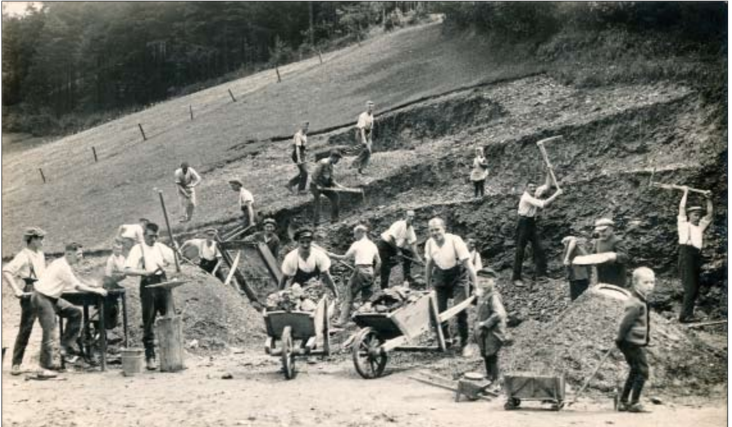
Der Turnverein Kleinolbersdorf legte 1925 auf dem steilen Hanggrundstück hinter dem Gasthof „Zur Erholung“ einen Sportplatz an. Der steinige Untergrund machte die Arbeit beschwerlich. Links eine Feldschmiede zur Instandhaltung der Arbeitsgeräte.
